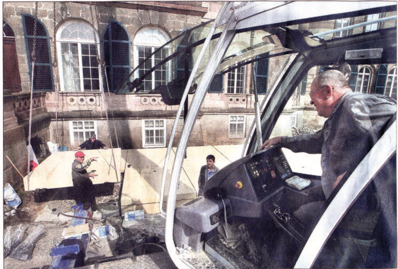
Terrassenbau am Kirchflügel: Kranführer Norbert Körner (rechts) sorgte am Wochenende zusammen mit seinen Kollegen von der Firma Stoll für den fachgerechten Zusammenbau der Beton-Fertigteile. Foto: Herzog
