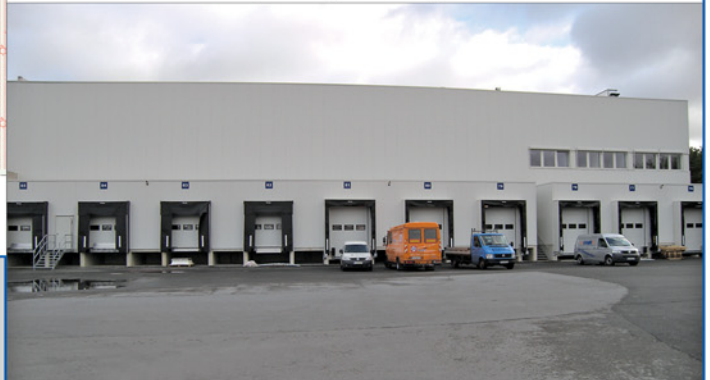
In der Bauphase – Montage der Hochregale
