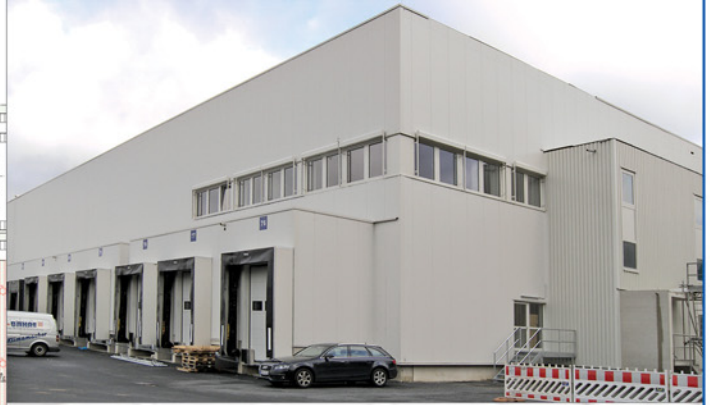
Fertigstellung Fleischlager – Ansicht von Westen
