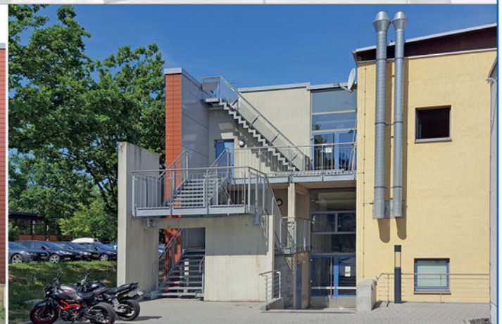
Teilansicht von Osten – Abriss und Neubau Außentreppehaus
