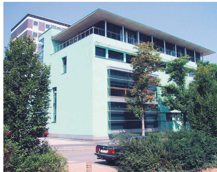
Justizbehörden Kassel, 1998 – 2005, Bauleitung
