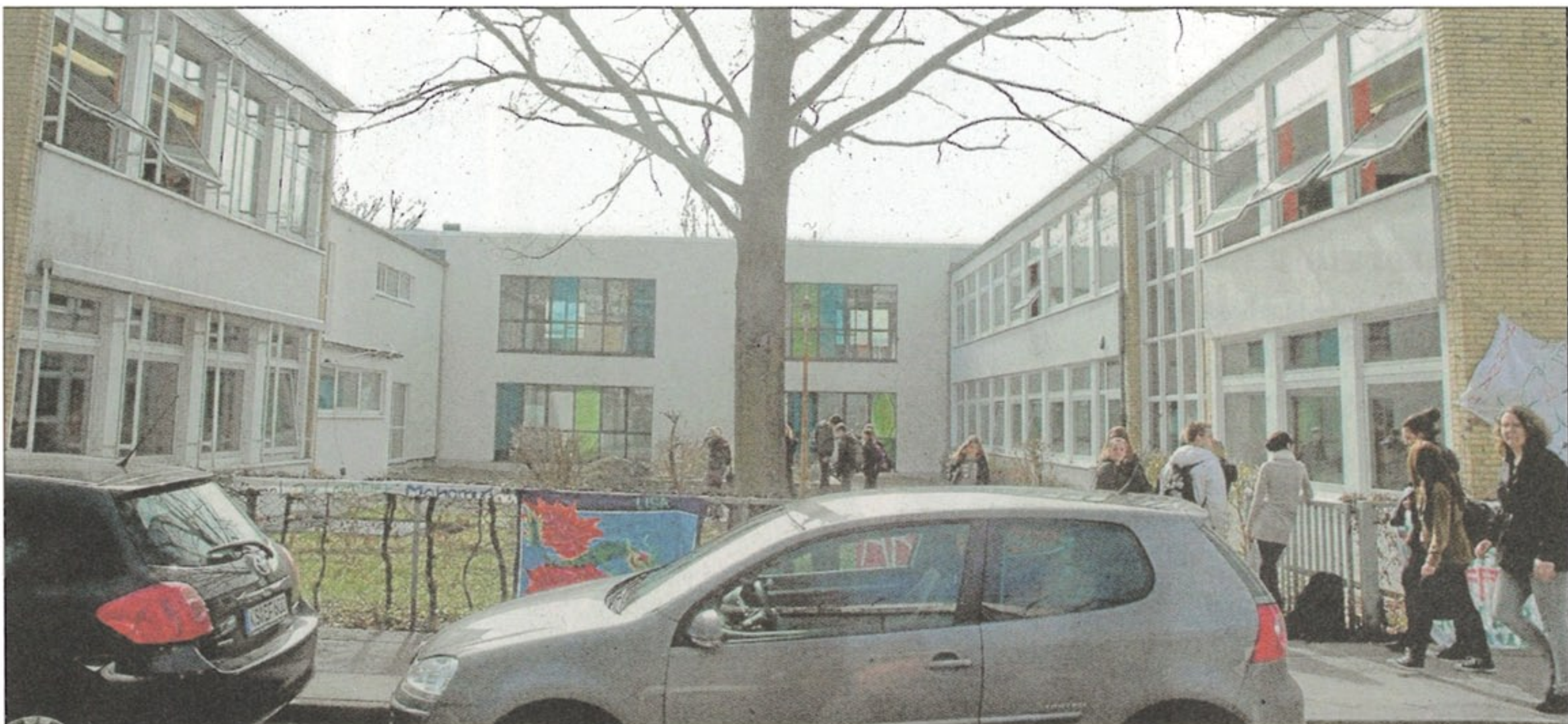
Markanter Bau mit viel buntem Glas: Der „Riegel“ (Mitte) verbindet die alten Pavillons (rechts und links) der Herderschule zu einer Einheit. Die Pavillons wurden in der Höhe an den Neubau angepasst.
