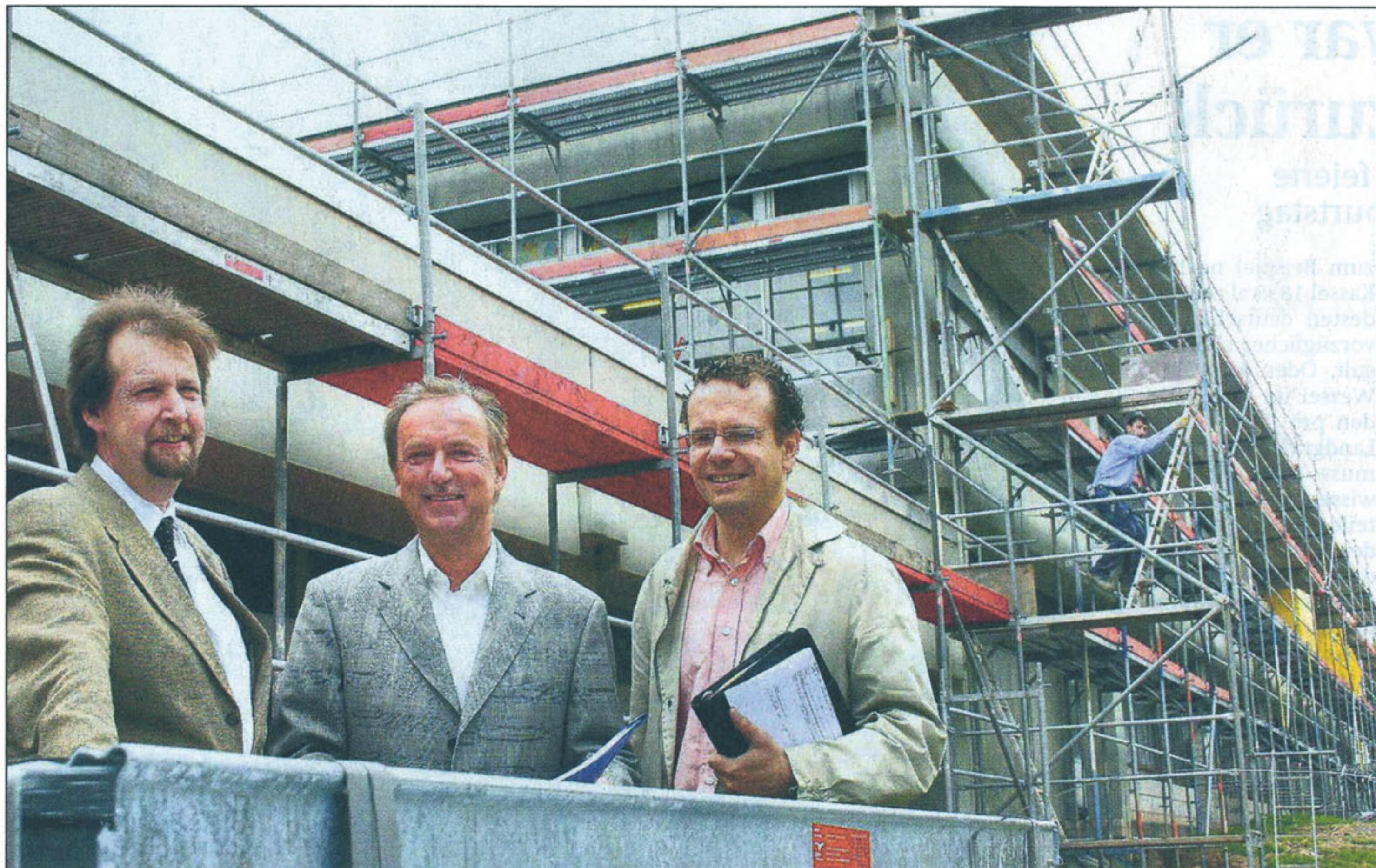
Sanierer: Vor der komplett eingerüsteten Nordseite der Gesamtschule Fuldataal von links Jürgen Happe von der GHT, einer Tochtergesellschaft der Landesbank Hessen-Thüringen, Architekt Joachim Schander und Thilko Gerke, Geschäftsführer der Kasseler Baufirma Rennert.
