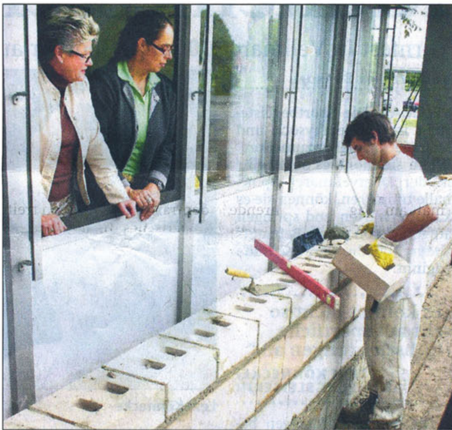
Bald eingemauert?: Schulleiterin Brigitte Bergholter (von links) und ihre Stellvertreterin Christine Saure blicken auf die Brüstung der neuen, vorgesetzten Fassade, die Alexander Blum mauert.
