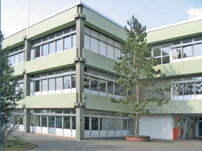
Ansicht Ostseite mit Kiosk - Vor der Sanierung
