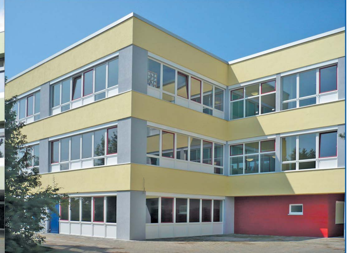
Ansicht Ostseite mit Kiosk - Nach der Sanierung
