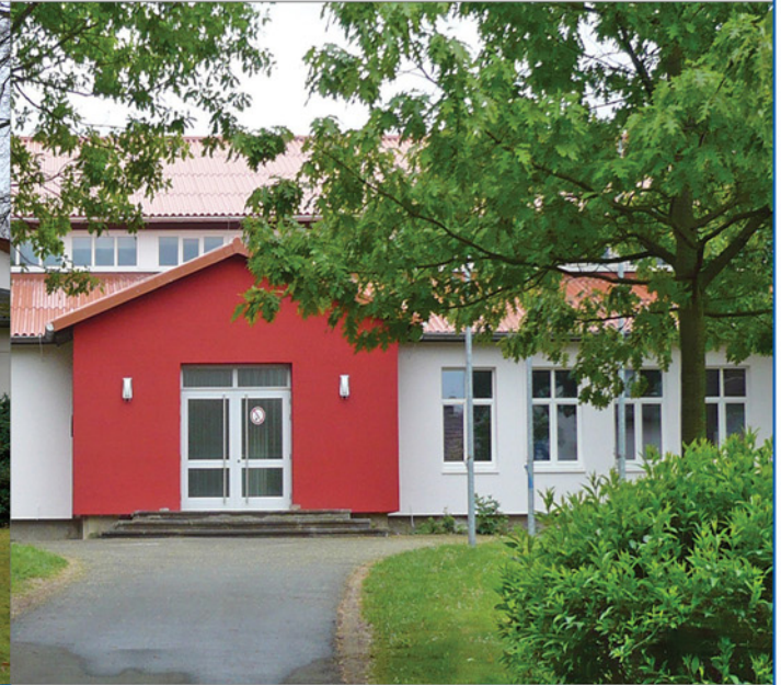
Eingangsbereich Mehrzweckhalle - Nach der Sanierung
