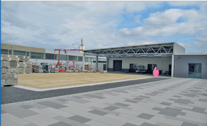
Teilansicht von Westen - Lehrbaustelle
