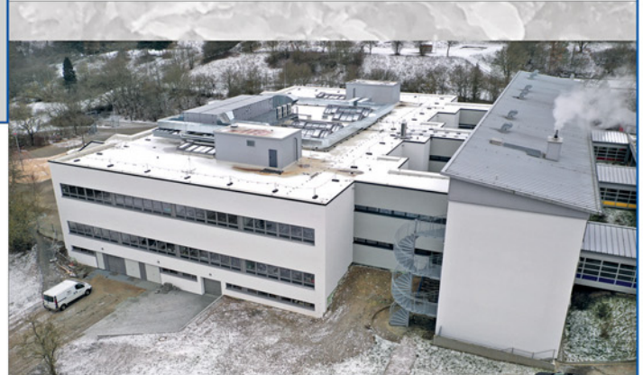
Ansicht von Norden - Nach energet. Fassadensanierung
