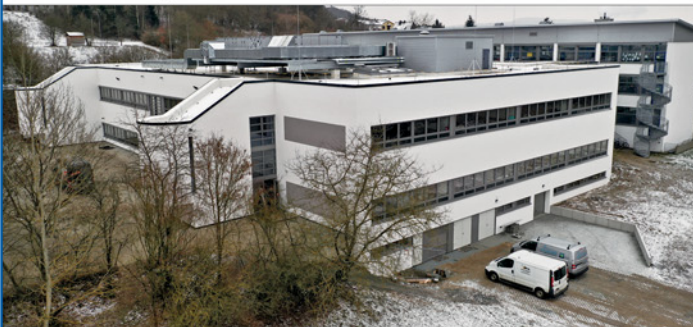
Ansicht von Nordost - Nach energet. Fassadensanierung
