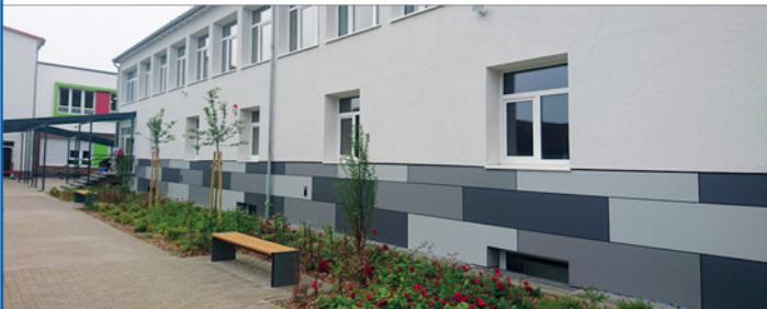
Vordergrund Verwaltung – Sanierung abgeschlossen
