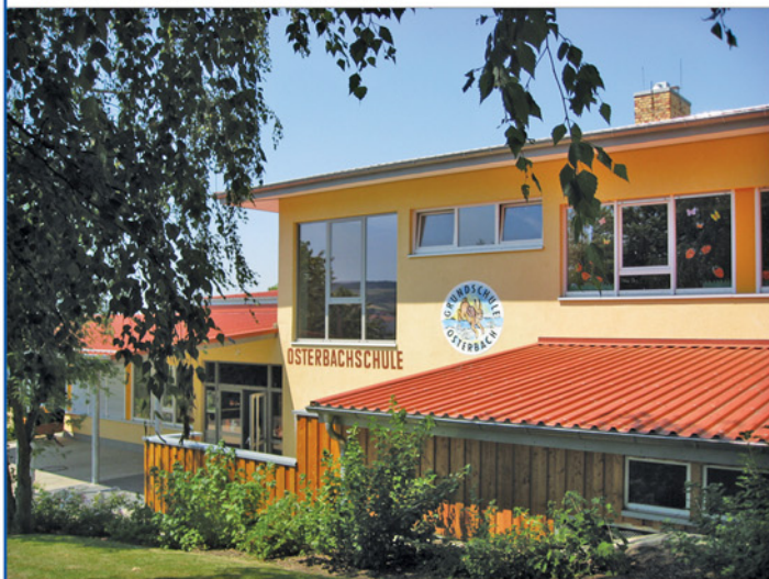
Teilansicht Grundschule Osterbach
