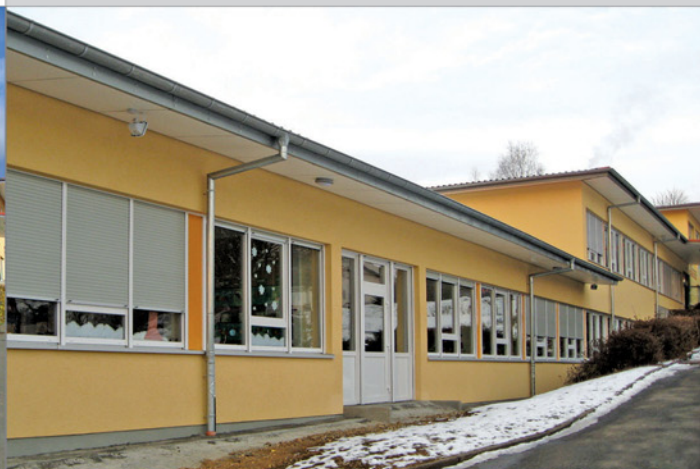
Außenfassade nach der Sanierung
