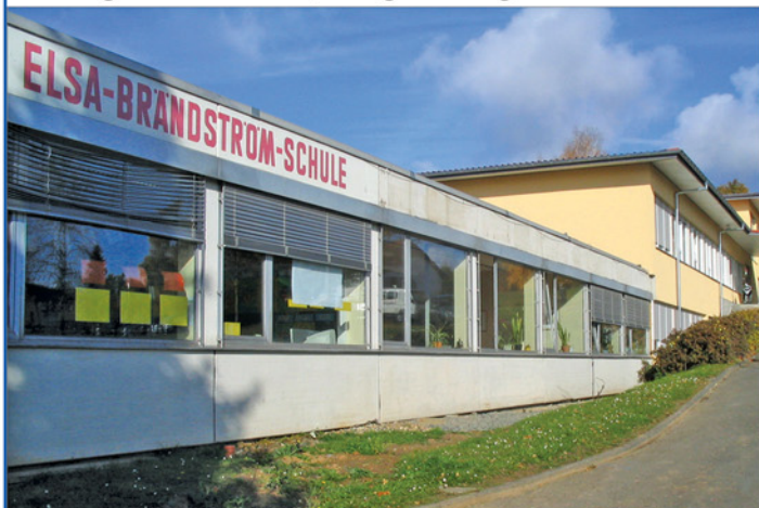
Vgr.: Integrierte Sonderschule, Hgr: Grundschule, Vor der Sanierung
