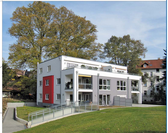
Schachtenstr. 22 - Ansicht Süd-West
