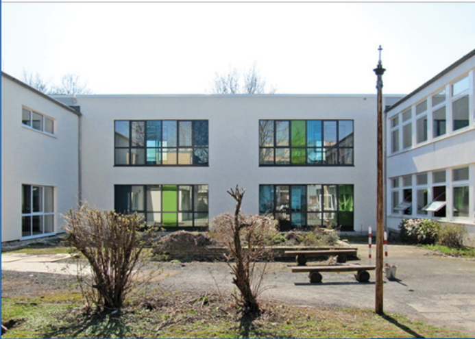
Teilansicht von Norden
