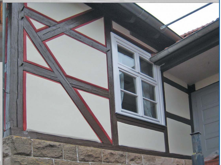
Fachwerk nach abgeschlossener Sanierung
