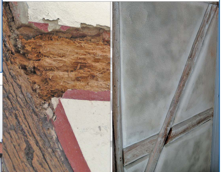
Entnahme des alten schadhaften Fachwerks
