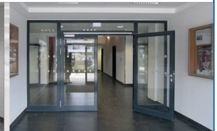
Eingang / Flure saniert
