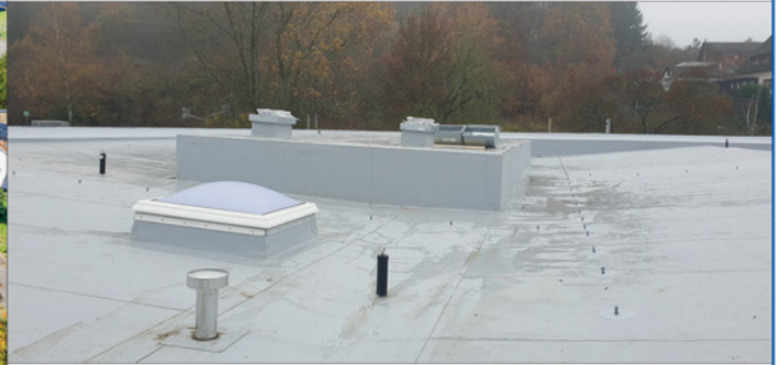
Flachdach – Foto Bestand
